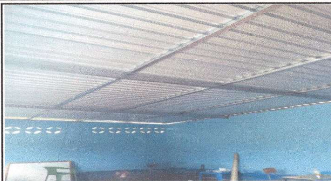
Foto 2: Colocación final de lámina troquelada aluzinc calibre 26
