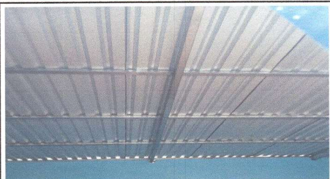
Foto 1: estructura final de soporte de metal
