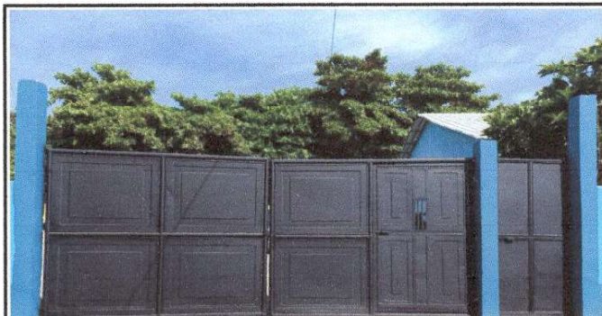
Foto 4: Mantenimiento a portón de metal
