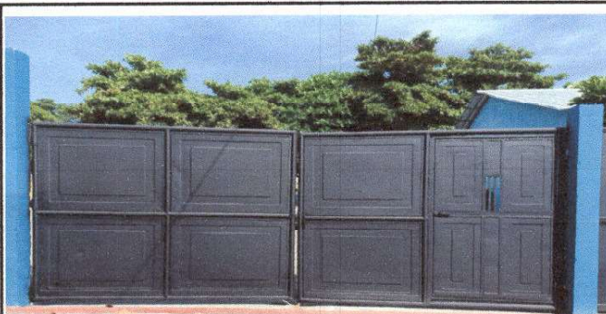
Foto 3: Mantenimiento a portón de metal
