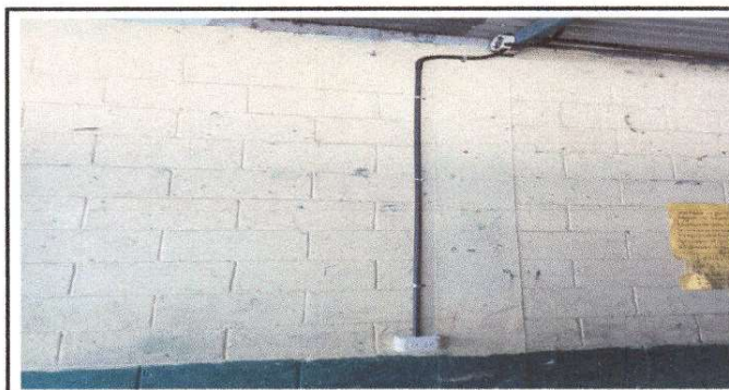
Foto 6: Reparación final del cableado eléctrico
